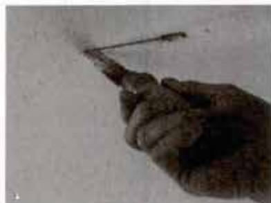
۱- سوراخی را در سقف ایجاد کنید.
